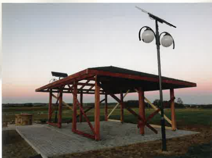
W TRAKCIE BUDOWY
